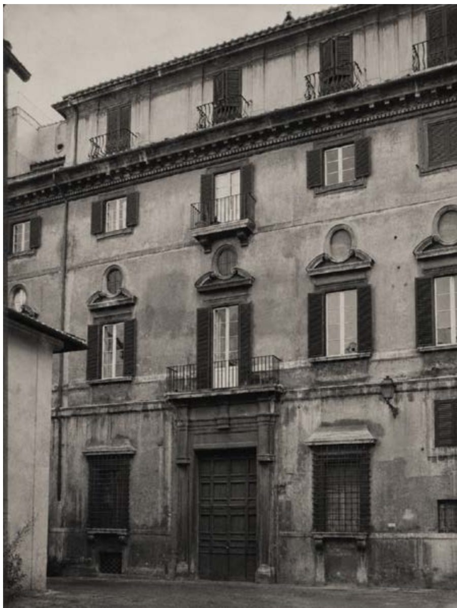
Palazzo Troili, na Piazza Campitelli. O quarto andar deste edifício foi residência do P. Dessons e da Comunidade SCJ de Roma entre 1899 e 1905.
